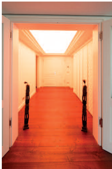
Die LED-Technik über der Spanndecke im Eingangsbereich bietet vielfältige Möglichkeiten der Inszenierung
