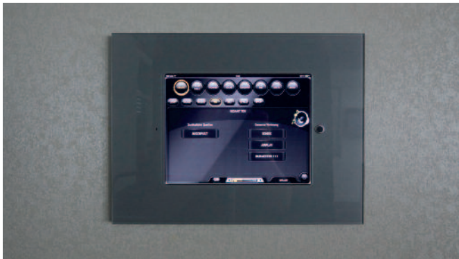
Perfekt verstaut wird das iPad zum zentralen Bedienelement der Installation mit Komponenten von Crestron
